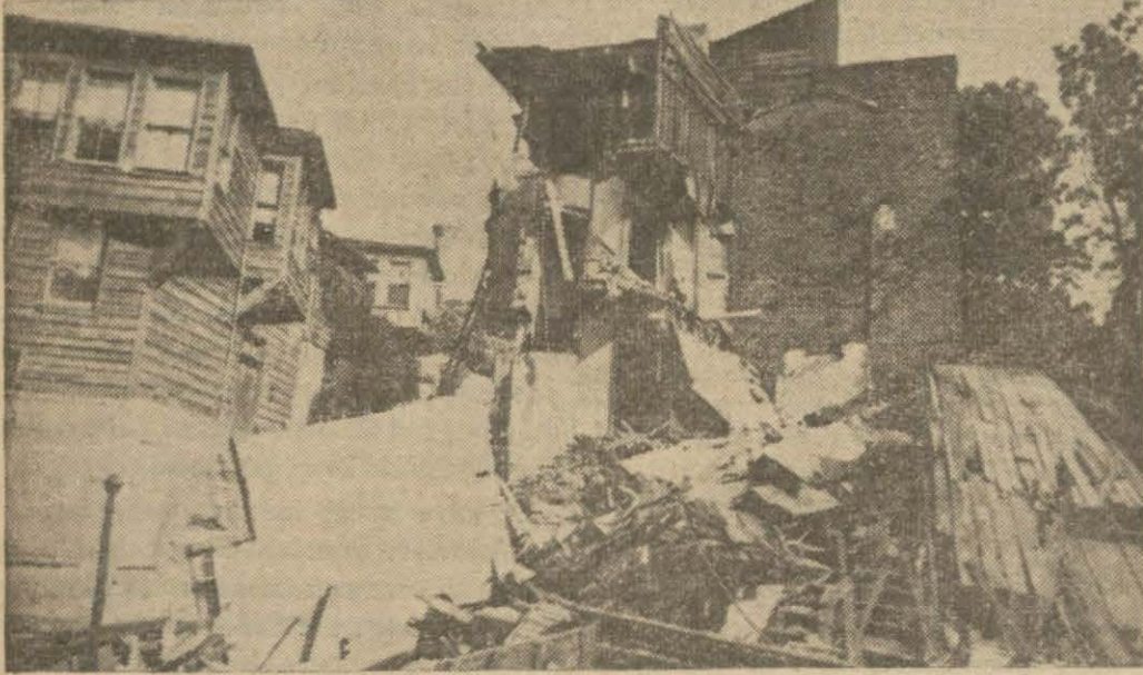
Yıkılan iki evin perişan manzarası
